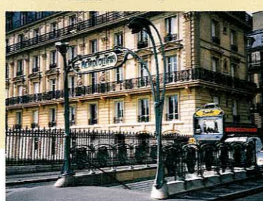
地下鉄入り口。当時一流の建築家ギマルの作
